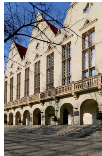
Gmach Główny Politechniki, elewacja południowa
