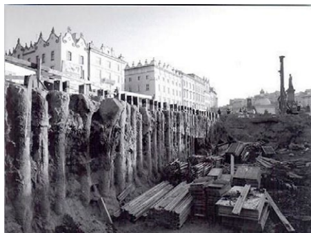
Fig. 16. Widok palisady z pali żelbetowych od strony wschodniej Rynku w początkowej fazie budowy (fot. MHK)
