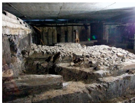
Fig. 13. Fragment odkrytych brukowanych trak-tów drogowych biegnących przez Rynek na tle ściany zewnętrznej z pali żelbetonowych w trakcie budowy (fot. A. Kadłuczka)
